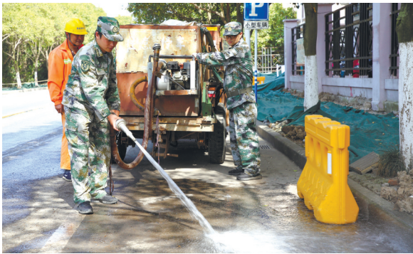
6月8日,学田街道基干民兵小分队走进龙王桥道路改造现场,对原有人行道板拆除后,容易产生扬尘等问题,积极配合施工单位,做好道路周边水马设置、遮尘网覆盖、道路洒水等工作,助力扬尘治理。 汤建军
