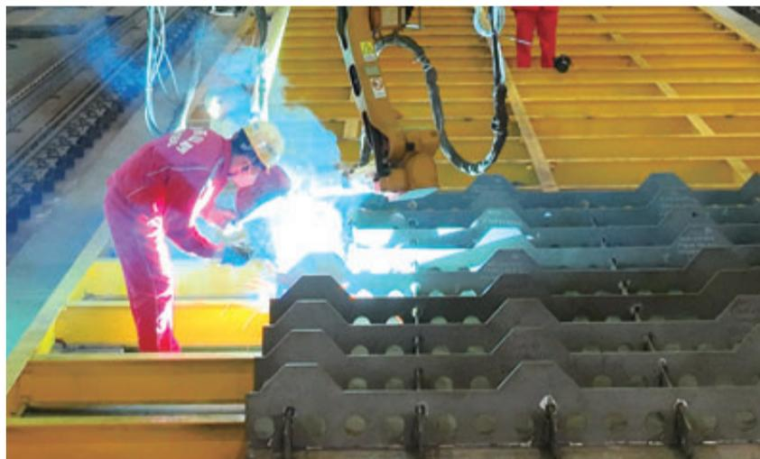
昨天,张靖皋长江大桥钢塔第一块板单元正在进行焊接作业。吴树建 薛冯
