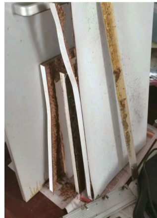
沈女士家中掉落的吊柜。 记者沈佳颖
