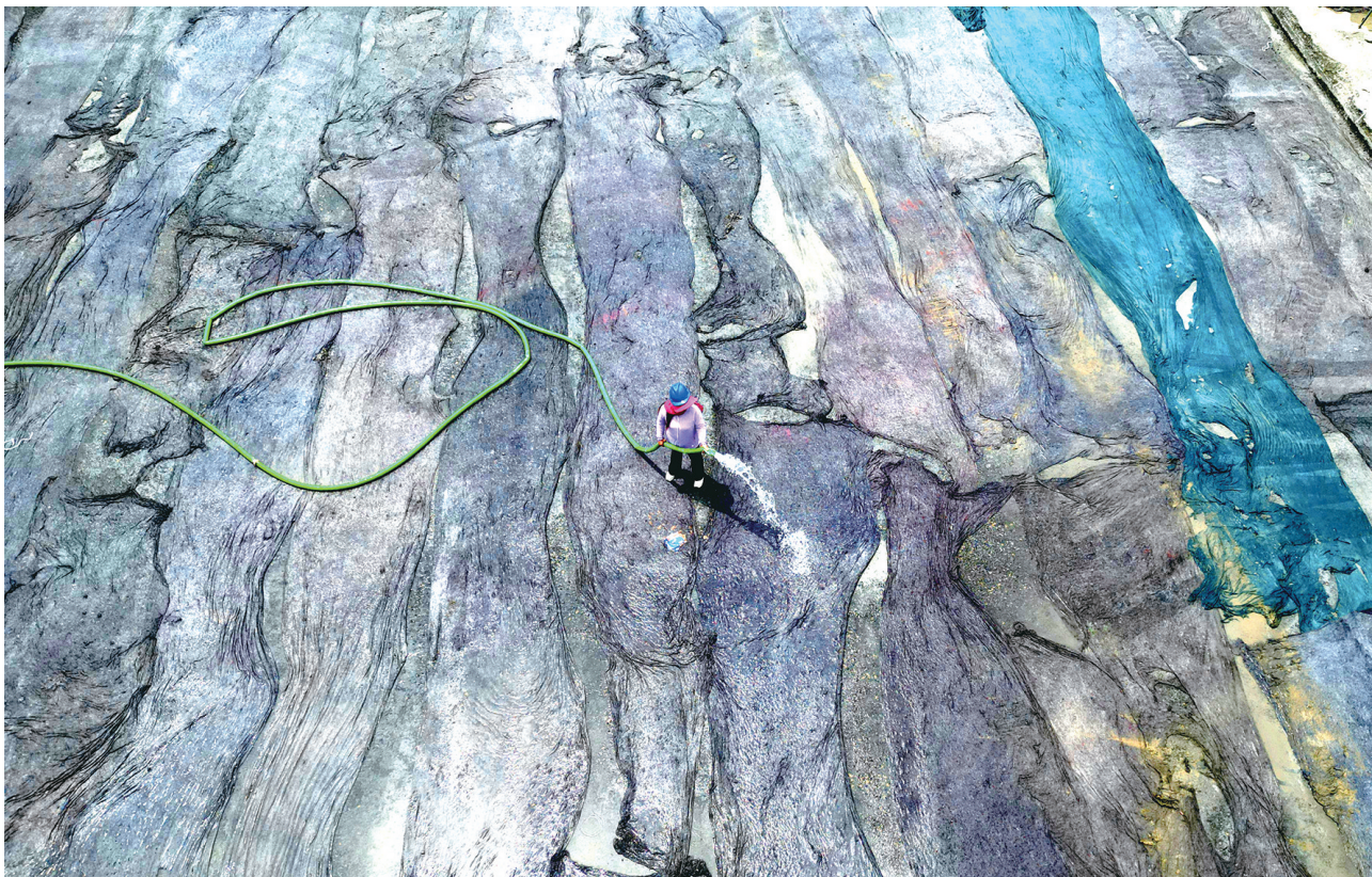
▲养护 七月二十五日,市区一建筑工地,一名女工冒着高温浇水,进行混凝土养护作业。 朱余水
