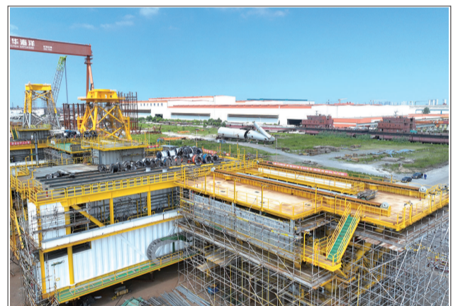
8日,在启东拍摄的中国海油蓬莱19-3油田钻机模块总包项目建造现场。近日,该项目WHPH/N钻机即将迎来主体结构封顶重大节点。据悉,中国海油蓬莱19-3油田钻机模块正式投产后,对保障国家能源安全,推动增储上产具有重要意义。 记者许丛军
