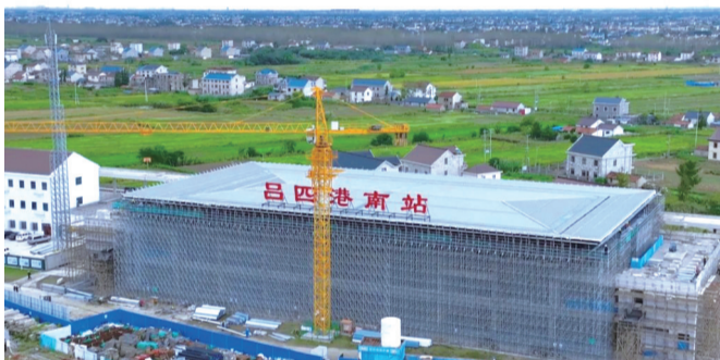
俯瞰吕四港南站。
