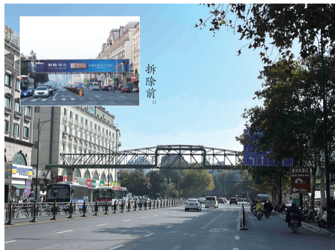
拆除广告后的现状。
