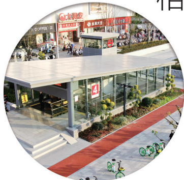
2号线北大街站彩色透水混凝土生态步道。
