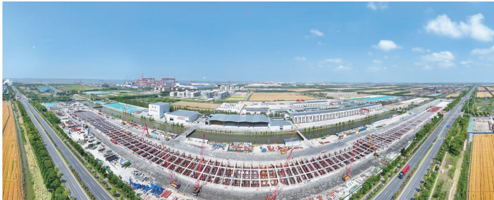
24日拍摄的由中铁十四局承建的海太长江隧道HT-A1标工程施工现场。据介绍,该标项目部正在进行结构混凝土施工,土方基本结束,42块底板混凝土预计6月初全部结束,盾构机正在加紧制造。
