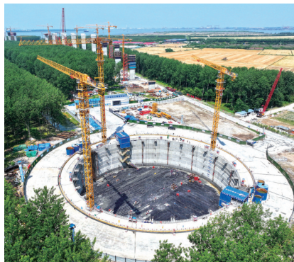
北航道桥南锚碇完成封底。
