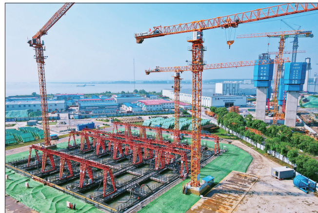
昨天拍摄的张靖皋长江大桥北航道桥北锚碇沉井基础下沉施工现场。
