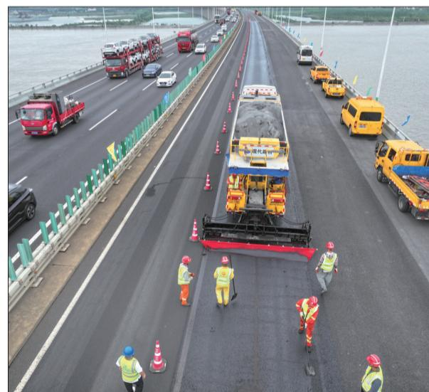
昨天拍摄的苏通大桥2024年度集约化养护工程“树脂基抗滑新技术”应用施工现场,这是苏通大桥桥梁医生联合实验室研发的树脂碎石封层和树脂乳化沥青抗滑磨耗层两项树脂基抗滑新技术在国内首次应用,该技术将有效提升路面抗滑性能与构造深度,实现行车安全性的大幅改善。
