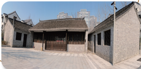
修整后的掘港城隍庙后宫和十二司
