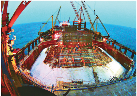
2005年5月11日,苏通大桥北主塔墩承台浇筑完成。
