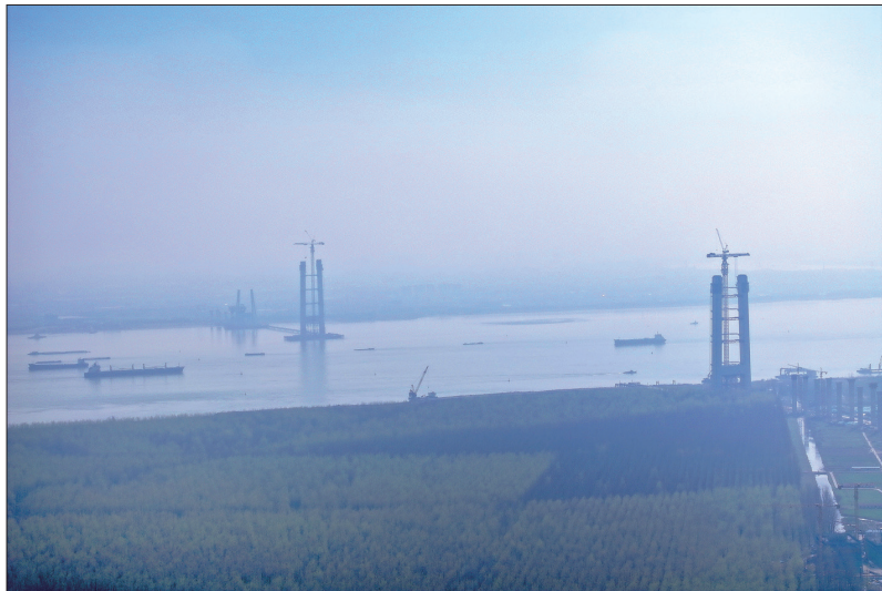
4月6日拍摄的世界最大跨度桥梁张靖皋长江大桥南航道桥南北主塔等建设现场。近日,随着张靖皋长江大桥南航道桥北主塔T19节段钢箱吊装完成,这座在建的世界最高悬索桥南北两座主塔高度均突破200米大关,工程建设取得阶段性进展。
