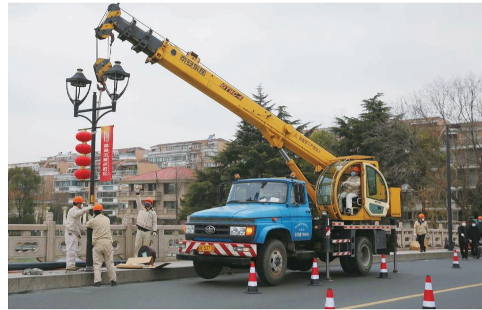
昨日上午,市城市照明处的技术工人正在为北濠桥14组桥灯进行更换作业。新桥灯与濠河景区风格相得益彰,且新桥灯采用Led光源也更加节能。
