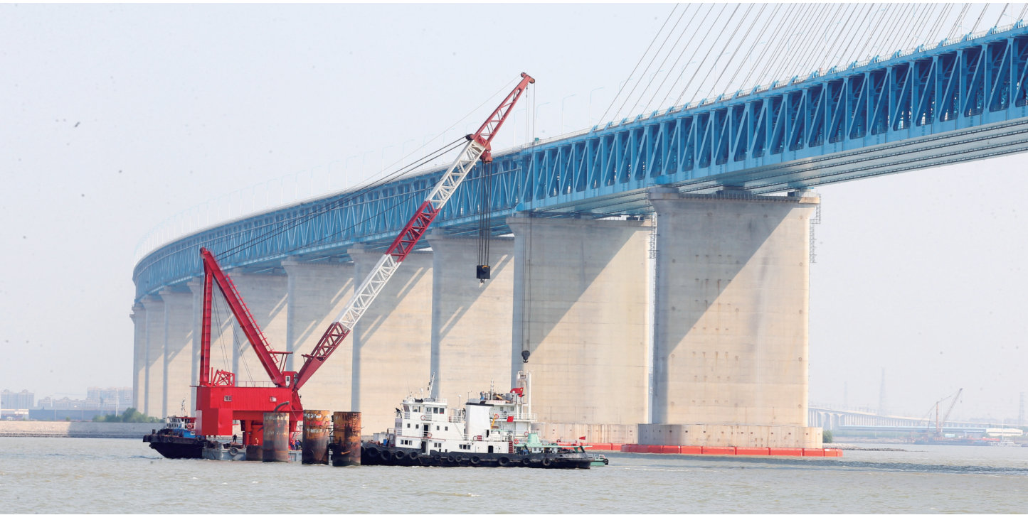
沪通长江大桥6套防撞设施近期陆续被分为28节段运送至26#至31#墩进行安装，为大桥穿“防护服”，这也标志着沪通长江大桥水上工程即将全面完成。图为昨天，工程作业船在加工调试防撞设施。
