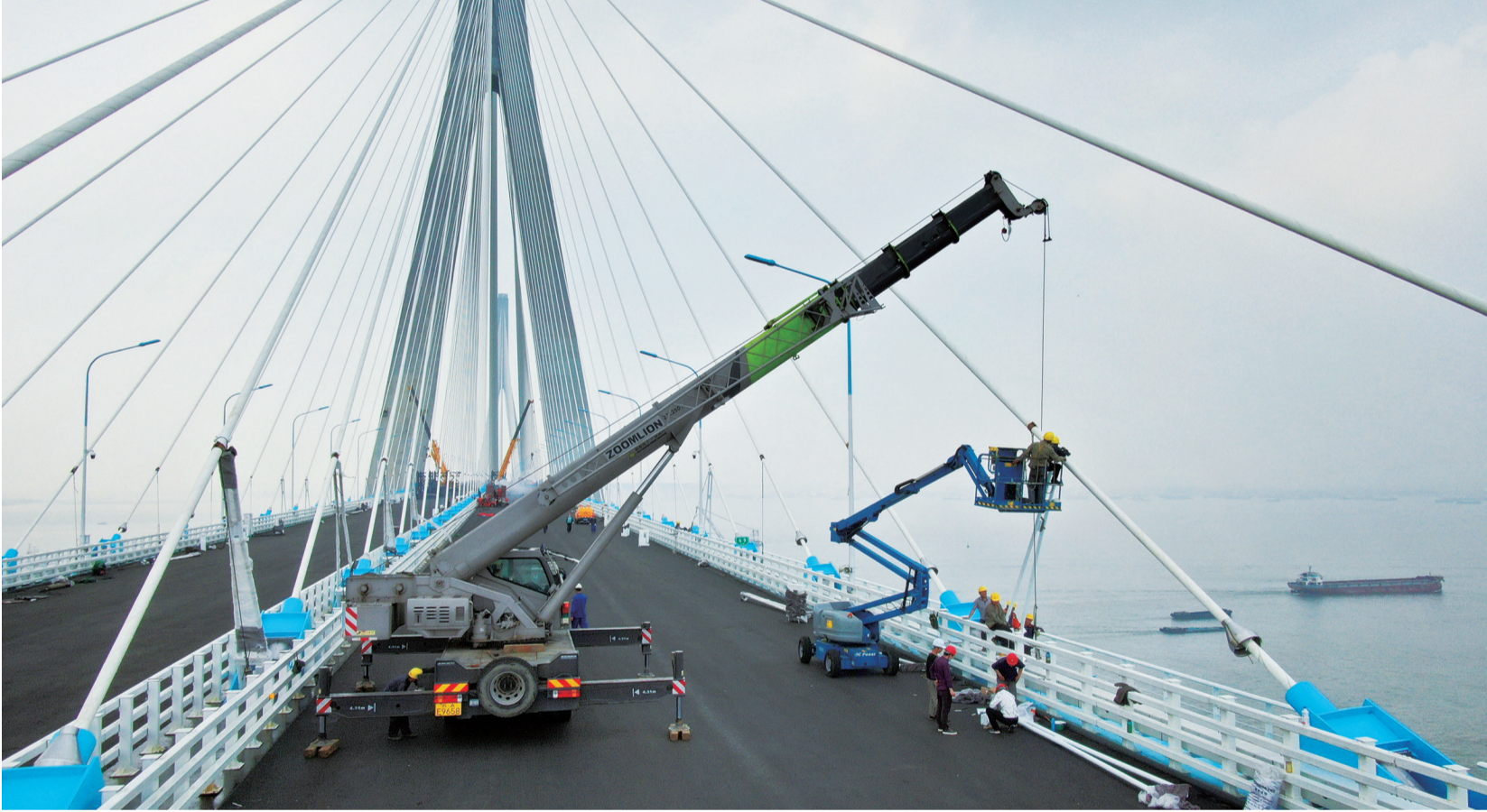
昨日，施工人员在主航道桥公路桥面上更换安装斜拉索阻尼器。沪通长江大桥共有432根斜拉索，每根斜拉索都需要安装永久阻尼器，阻尼器能确保斜拉索在风的阻力下不产生共振，从而减轻桥梁因大风、大雨或者车辆行驶过程中引起的振动，可以延长桥梁使用寿命。施工单位在五一期间开始更换安装，预计5月下旬可安装完成。
