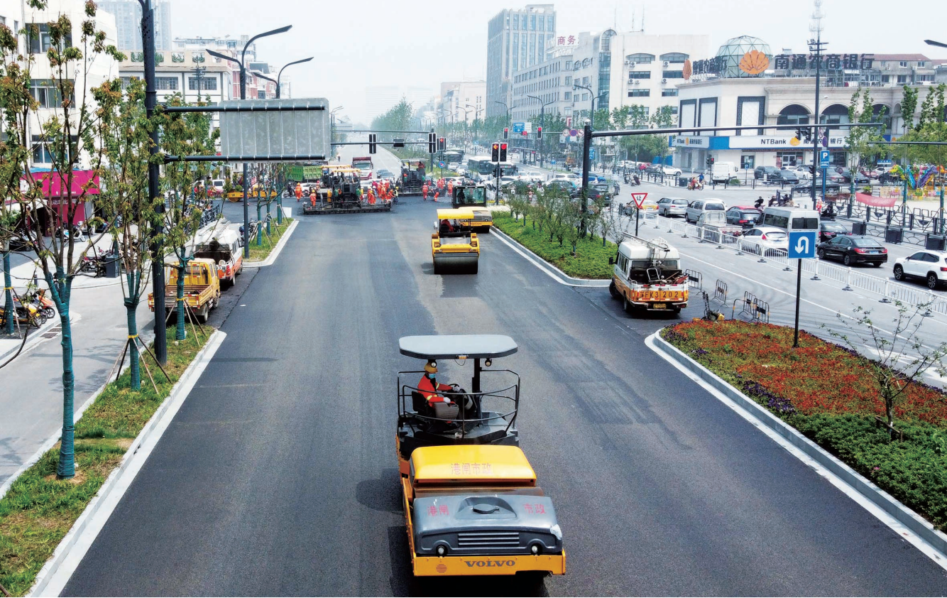
昨日,工农路提升改造(一期)工程(江海大道-人民路)进行沥青摊铺施工,标志着该工程进入最后收官阶段。该段道路建成通车后,将进一步提升主城区南北向通行能力。
