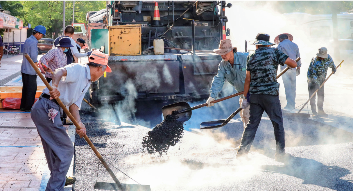
昨天,工人冒着高温在市区和畅路上摊铺沥青路面。此项目为老旧小区周边支路改造项目之一。 钱咸华摄
