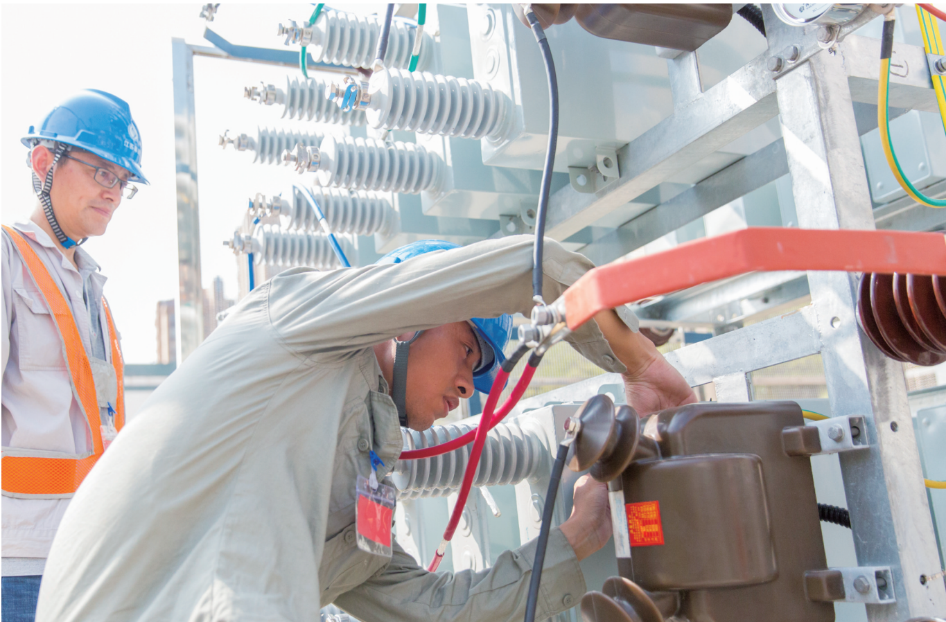
25日，国网如皋市供电公司运维人员在110千伏如皋变电站，安装容量4800千伏安电容器一台，并完成配套电缆的敷设和调试工作，为夏季用电高峰提供坚强的电网保障。
