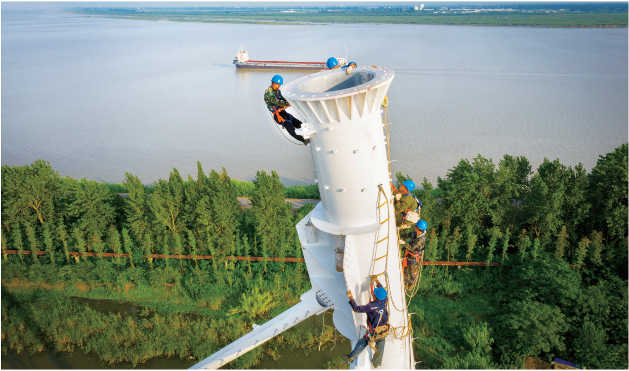
13日，500千伏海门东洲—上海崇明输电工程开始关键的跨江主塔立塔施工。施工人员冒着酷暑，早五点晚七点避开高温时段加紧施工，争取九月底开始展放导线。据介绍，主塔高204米，两座主塔跨距近1690米，横跨长江北航道海门和崇明岛之间。
