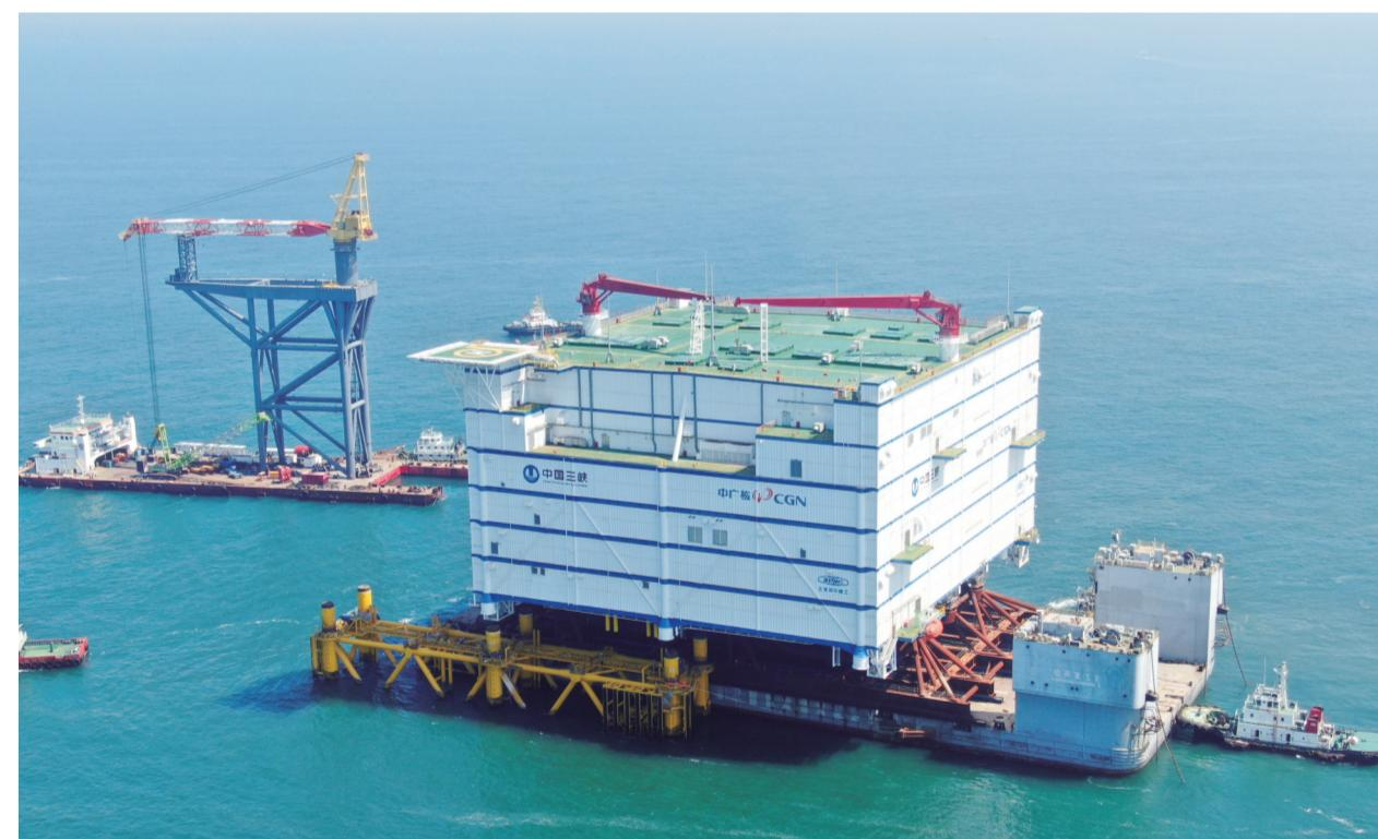
类似挺举的方式,一步式完成毫米级精准对接,实现了数万吨载荷的平稳转移。
