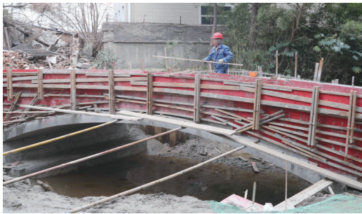
施工人员正在劝学桥上进行栏杆模块支护。
