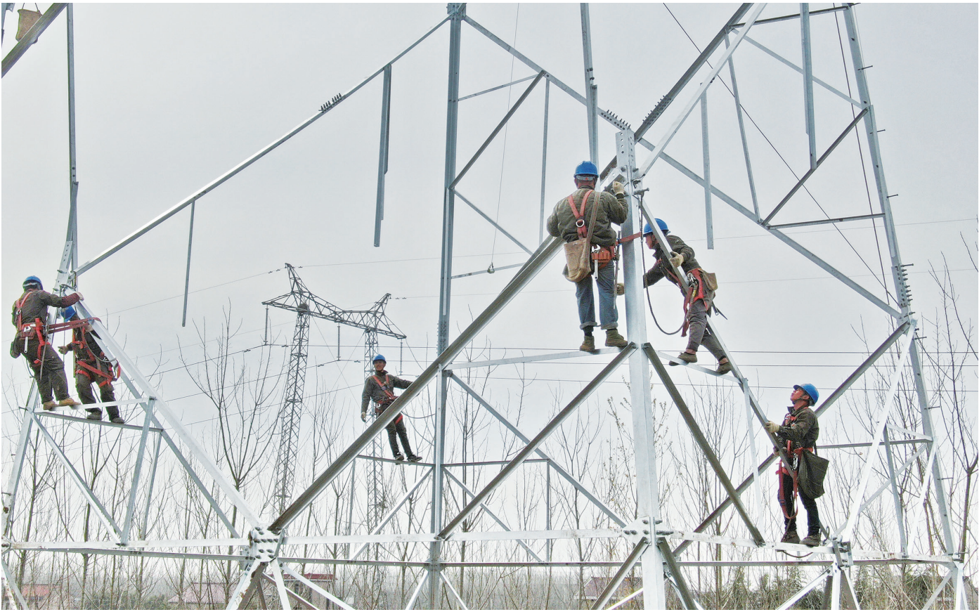
昨天,施工人员在启东北新镇铁塔组立现场进行高空作业。据了解,作为我市迎峰度夏工程的南通六匡~红阳港220千伏线路改造项目,目前80基的基础完成了79基,铁塔组立完成了8基。该工程于2021年11月26日开工,将新建双回杆塔80基、新建双回220千伏线路25.7公里,六匡变扩建220千伏间隔一个。工程将于6月5日竣工投运。 记者 许丛军摄
