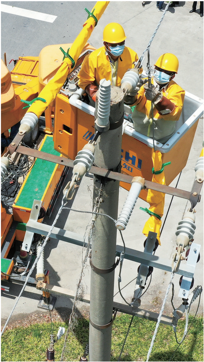
近日，国网如东县供电公司带电作业班工作人员在掘港镇10千伏宾发线32号杆处开展带电作业更换故障刀闸。 张浩摄
