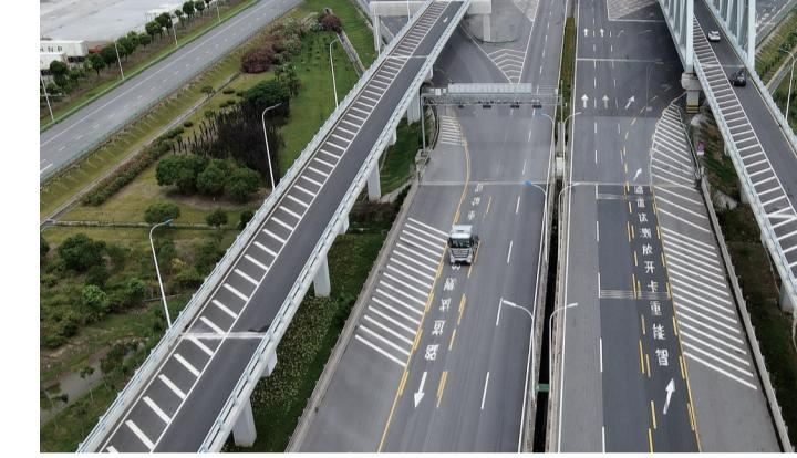
昨日,东海大桥上设置的智能重卡开放测试道路。当日,随着上汽集团智途旗下的5G+L4智能重卡在东海大桥位于上海一侧的引桥下出发,智能重卡在高速公路场景下的队列跟驰自动驾驶“减员化”运营测试也正式启动。
