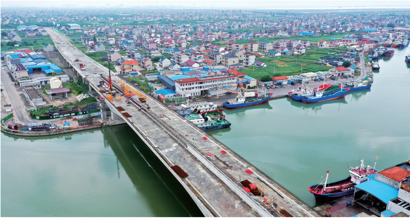
26日,航拍鹤港大桥建设现场,桥体主跨已经合龙,进入收尾阶段。鹤港大桥位于启东吕四港镇,横塘通吕运河,为三级航道标准桥梁。桥宽25米,主跨长120米,预计10月初完工通车。 潘杨摄
