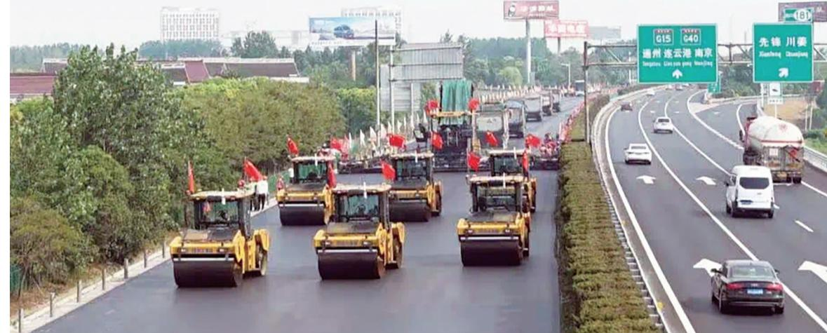
本报讯 (记者蒋娇娇 通讯员周宪文)近日,“无人集群摊铺碾压”技术在通启高速路面大修养护工程中成功实施,现场1台摊铺机与7台双钢轮压路机紧密配合,按照设定程序有序进行沥青路面施工协同作业(上图 周宪文摄),标志着该技术开始在江苏省公路工程建设领域中推广应用。
