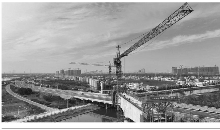
2日拍摄的洋吕铁路跨G328国道m连续梁施工现场。据介绍,该处施工是中铁十四局洋吕铁路项目跨度最大的悬灌梁。洋吕铁路全长约85公里,总投资约99亿元,建设总工期3年。记者 许丛军摄
