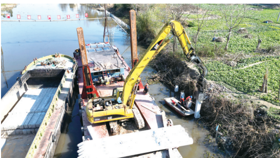
昨天,水利工程队在海安通扬运河胡集街道段进行岸坡防护桩施工。连日来,海安抓住晴好天气,投入资金组织人员和机械设备冬修水利,为来年的农业生产、农民增收打下基础。 顾华夏摄
