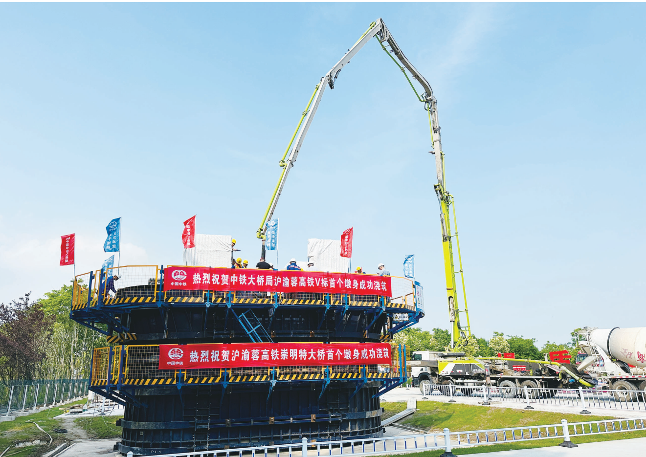
25日下午3时38分许,在上海市崇明区港东公路200#施工现场,经过7个小时的连续鏖战,沪渝蓉高速铁路崇明特大桥首个墩身浇筑完成,标志着大桥进入墩身施工新阶段。崇明特大桥南接崇太隧道,北接崇启公铁长江大桥,全长19.07公里,是北沿江高铁通道的重要组成部分。
