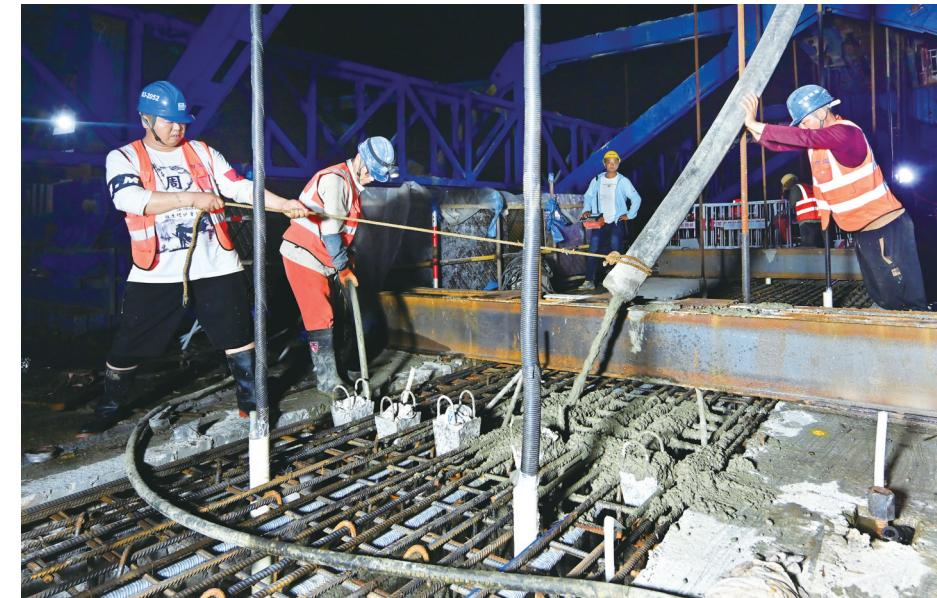
昨天凌晨三时许,南通绕城高速建设又迎重要节点,疏港航道特大桥左幅中跨顺利合龙。来自中建一局的疏港航道特大桥建设者们挑灯夜战,历经3个多小时的混凝土浇筑作业,疏港航道特大桥悬浇梁左幅中跨顺利合龙。
