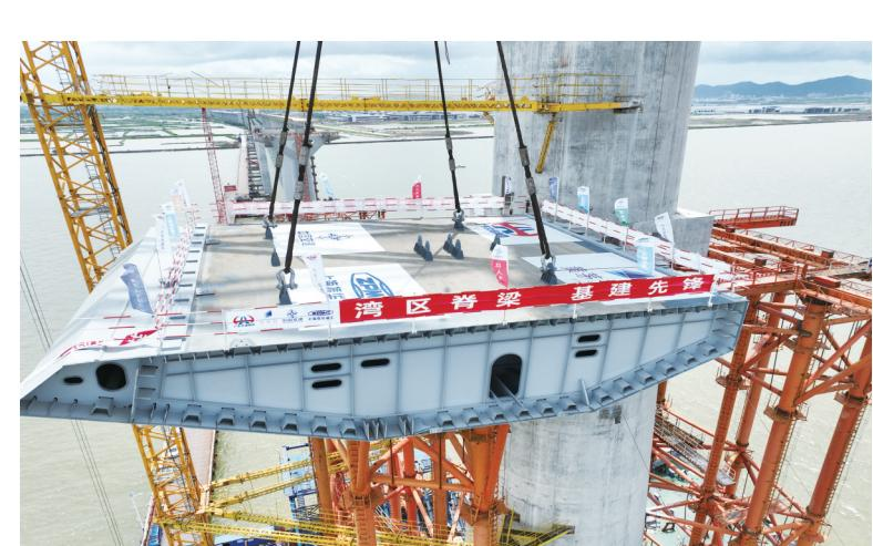
6月19日上午11时,经过近3小时的持续定位和挂钩,振华重工为黄茅海跨海通道高栏港大桥建造的首幅钢箱梁平稳落在既定位置,成功完成首吊作业。标志着该项目建设迈入了新阶段。
