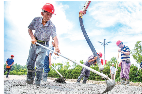
4日,海安上湖湖东市民集散广场工地上,工人们正在进行混凝土浇筑作业。进入夏季,建设者们不惧高温,坚守岗位,全力推进项目工程建设进度。 瞿慧勇 王非非摄
