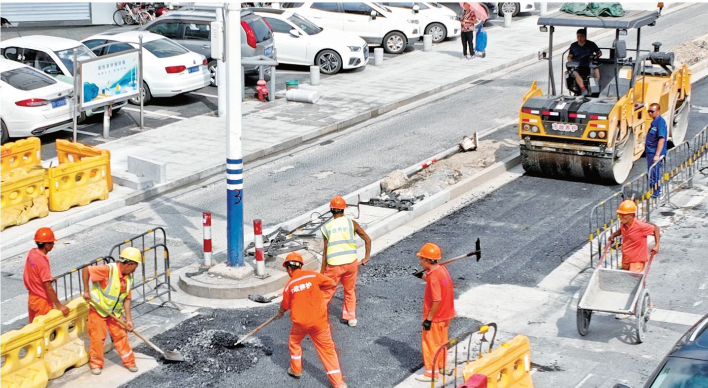
19日,南通地铁2号线和平桥站点周边路面正在摊铺沥青,人民路、濠西路、跃龙路路口畅通指日可待。和平桥站点为地铁1号线与2号线换乘站。
