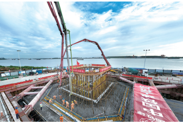
8月31日,张靖皋长江大桥北航道桥北索塔承台混凝土浇筑施工顺利完成,成为全桥首个浇筑完成的主塔承台,标志着大桥建设正式进入钢塔施工阶段。 记者 许从军摄
