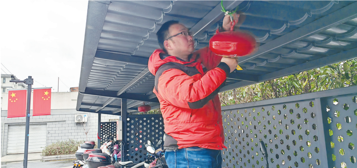
▲和平桥街道濠北社区北濠桥新村内工人们正在为室外电动车棚安装“灯笼式”自动灭火装置。 赵东亚摄
