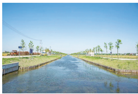
悦来镇农田旁的河堤修筑了生态护岸。
