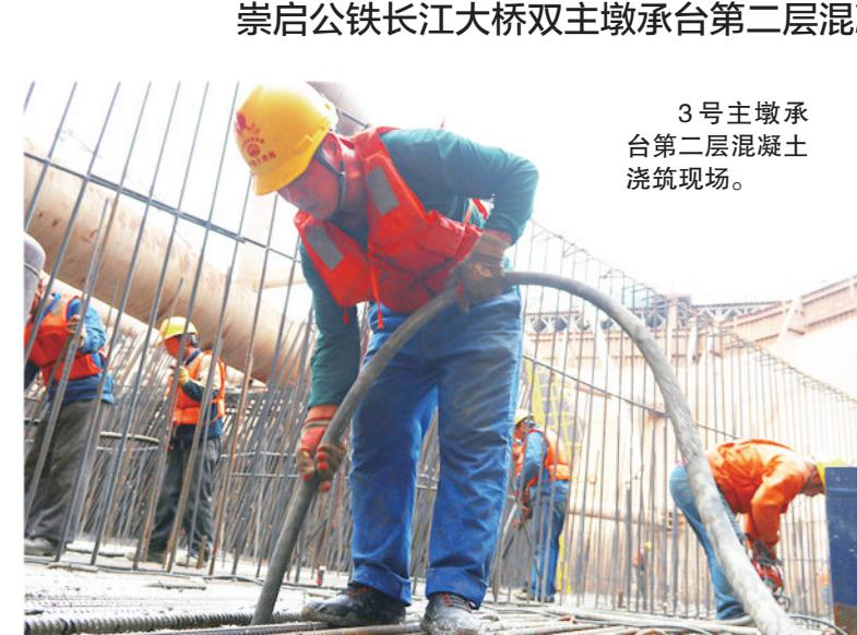
3号主墩承台第二层混凝土浇筑现场。
