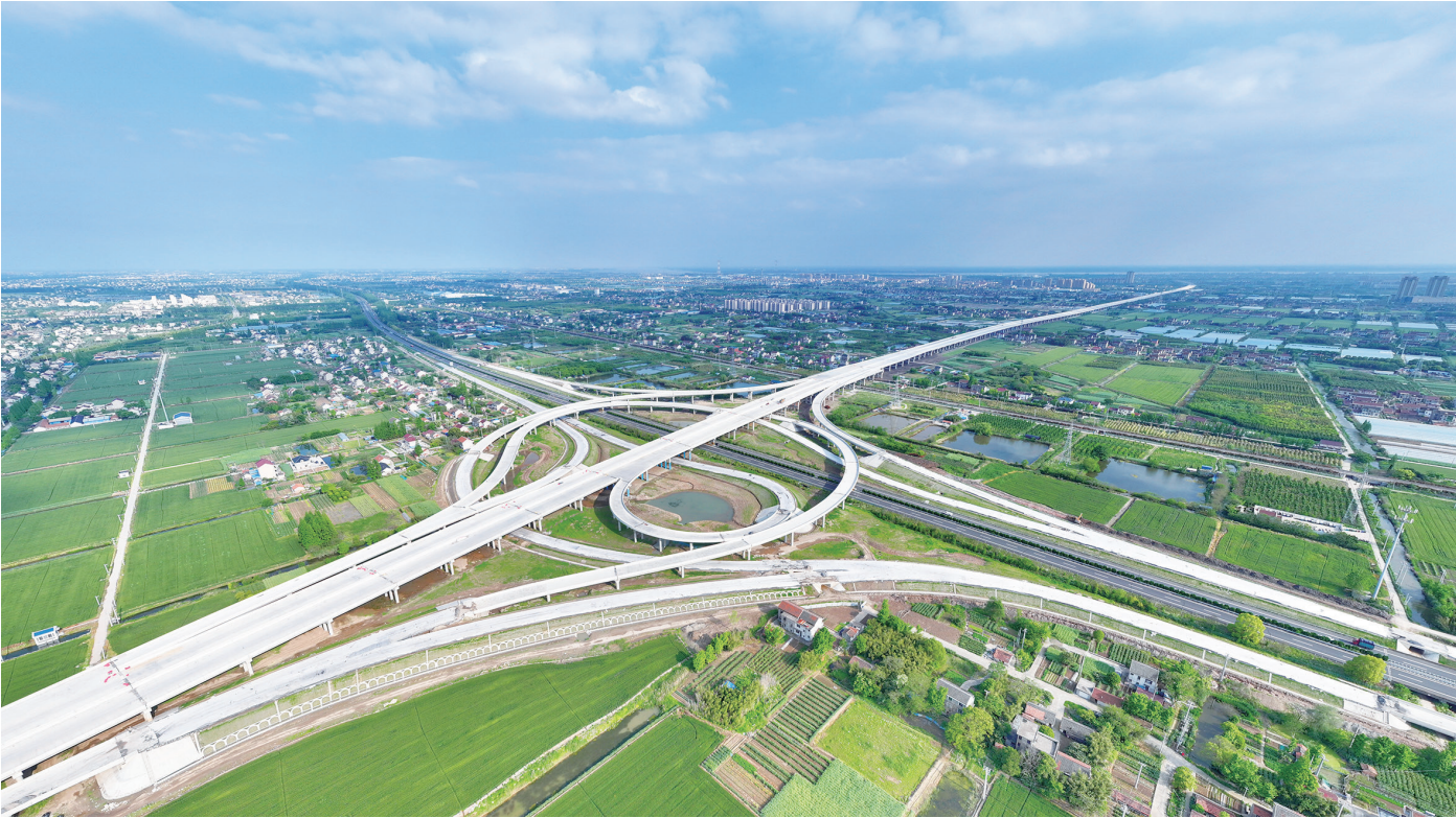
4月29日，南通绕城高速海门东枢纽新貌。南通绕城高速（通锡高速）海门东枢纽是海门至通州段全线控制性工程之一，与沪陕高速互通，枢纽内有主线桥一座和匝道8条，目前将进入路面沥青摊铺阶段。
