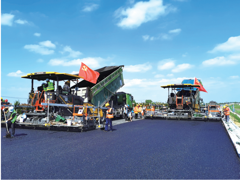
沥青下面层试验段施工现场。 解麒麟摄
