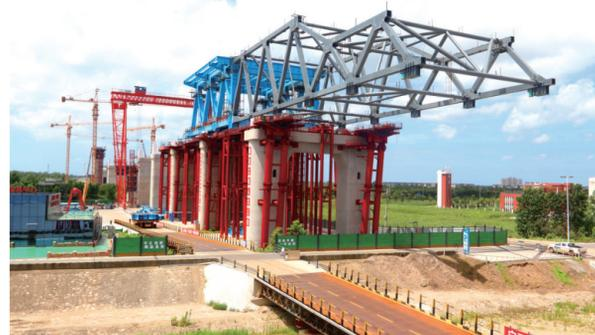
24日,沪渝蓉高铁V标崇启公铁长江大桥非通航孔桥钢梁E0—E3第一轮顶推完成。这一重大施工进展,为后续钢梁架设和连续顶推施工创造了有利条件。据悉,非通航孔桥顶推共13轮87次,每次顶推14米,第一轮顶推56米,今年共计划顶推4轮。崇启公铁长江大桥跨越长江北支,分为主通航孔桥、非通航孔桥、南北岸公铁合建引桥、南北岸单建铁路引桥,是新建上海至南京至合肥高速铁路重点控制性工程。彭军君文 孟庆虎摄
