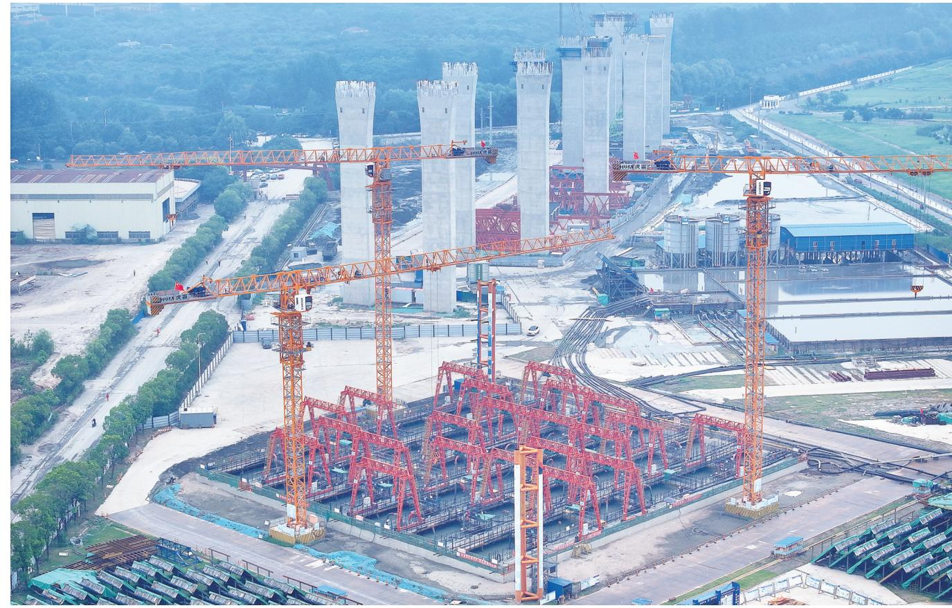
昨日在如皋市长江镇拍摄的由中交一公局承建的张靖皋长江大桥北航道桥北锚碇沉井基础施工现场。该项目已完成沉井地基处
