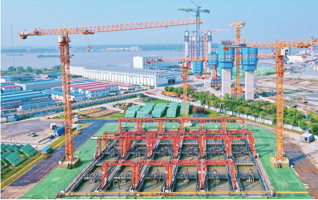
23日拍摄的如皋境内的张靖皋长江大桥北航道桥北锚碇沉井基础下沉施工现场。
