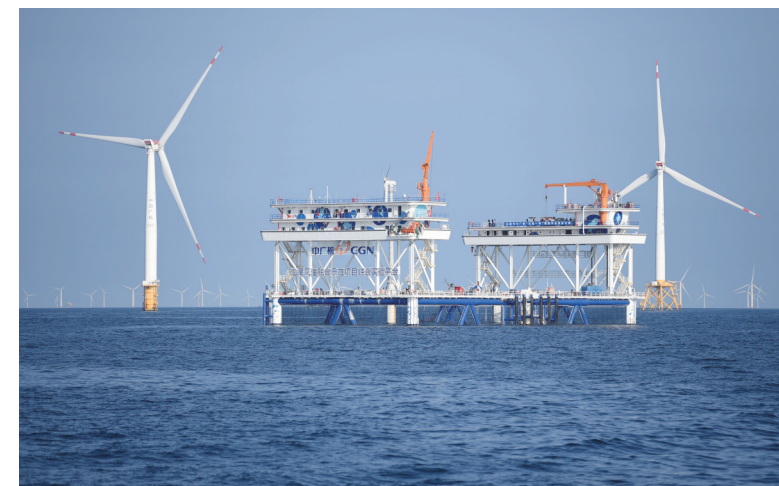
这是9月2日拍摄的中广核“伏羲一号”风渔融合网箱平台。9月4日，超大型风渔融合网箱平台——中广核“伏羲一号”正式在广东汕尾建成投运，预计年产优质海水鱼类约900吨，项目对于我国“海上风电+海洋牧场”产业融合发展具有重要示范意义。
