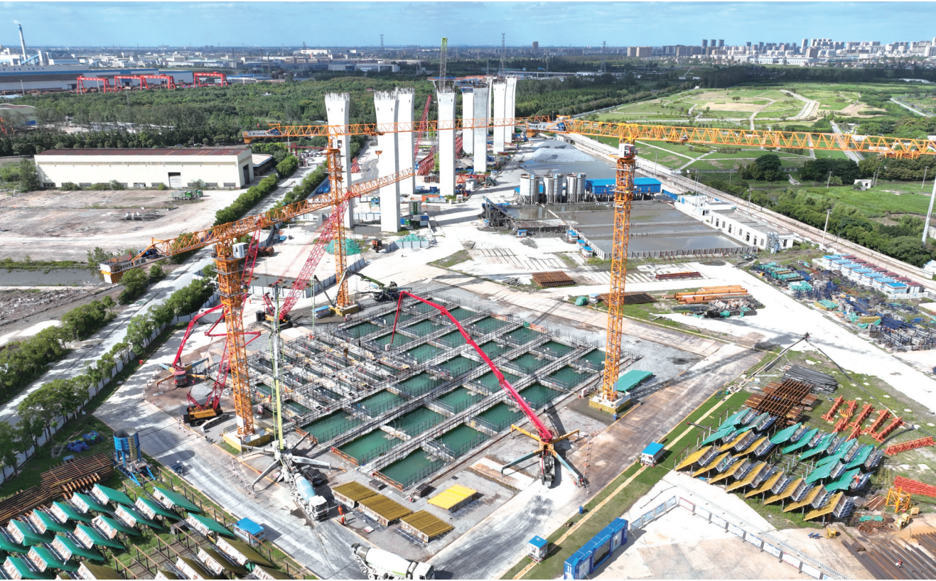
23日晚，随着最后一方混凝土灌注完成，国内公路桥梁最大的沉井基础——张靖皋长江大桥北航道桥北锚锭沉井基础封底施工完成，下一步将启动沉井填芯施工。
