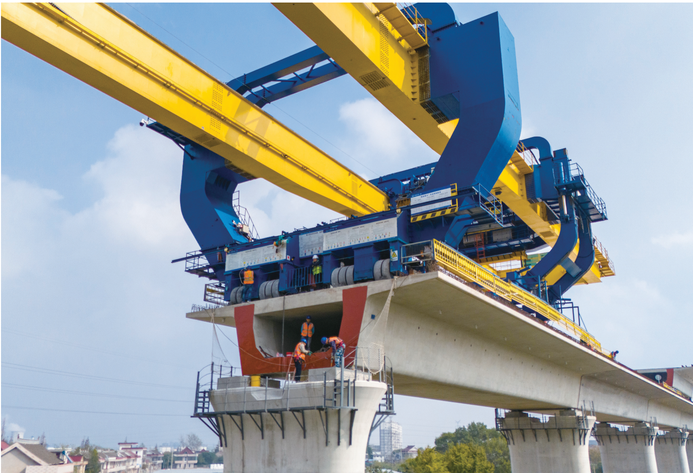
昨天，位于通州区的中铁一局沪渝蓉项目南通特大桥建设现场，工人正在进行架梁作业。沪渝蓉高铁是国家“八纵八横”高铁骨干通道之一，线路总长约2100公里，全线设计时速350公里。
