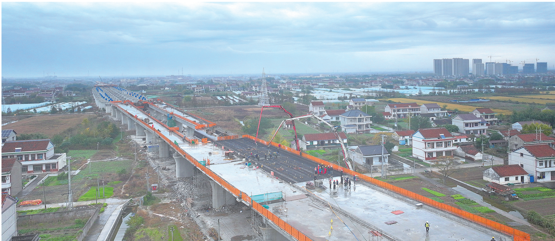
昨天,经过连续15个小时的施工,启东西站双线夹渡线道岔连续梁顺利浇筑完成,标志着由中铁上海工程局承建的沪渝蓉高铁沪宁段启东西站道岔连续梁全部浇筑完成,进一步畅通梁梁通道,为后续推进车站施工按下了“加速键”。
