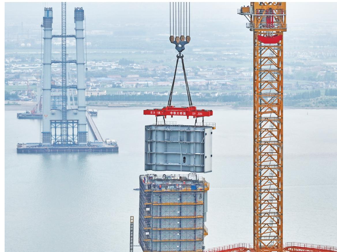
17日，张靖江长江大桥南航道桥北主塔T20节段钢箱吊装圆满完成。在大桥建设者的精准操作下，随着15000吨米级塔吊缓慢上升，一块重达275吨、高10.8米的钢塔节段在200米高空完美对接。截至目前，北主塔已成功攀升至219米的新高度，累计完成进度69%。
